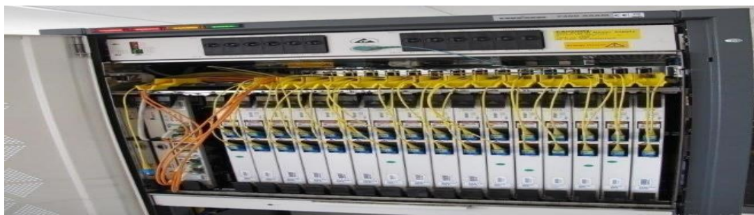
3.1 - сурет – OLT (оптикалық желілік терминал)
